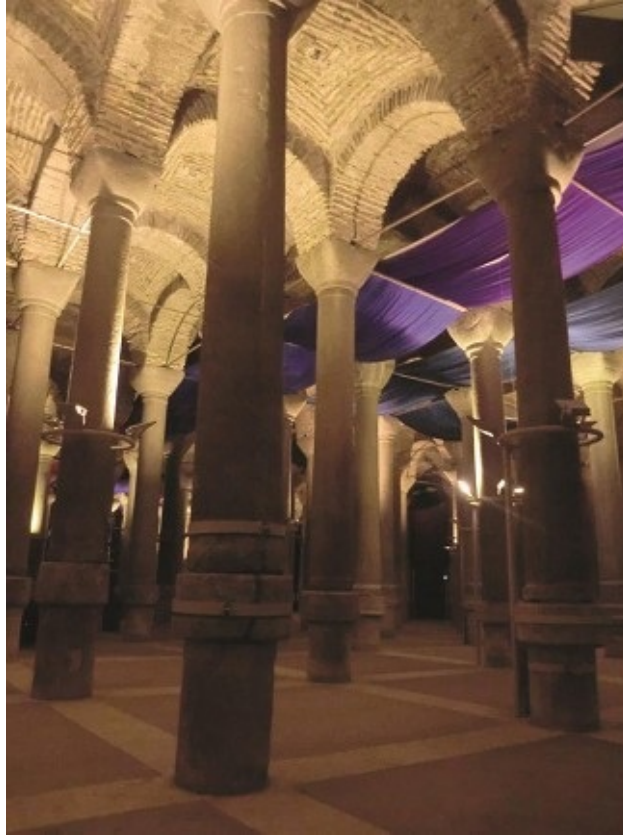
Cisterna romana subterránea.
