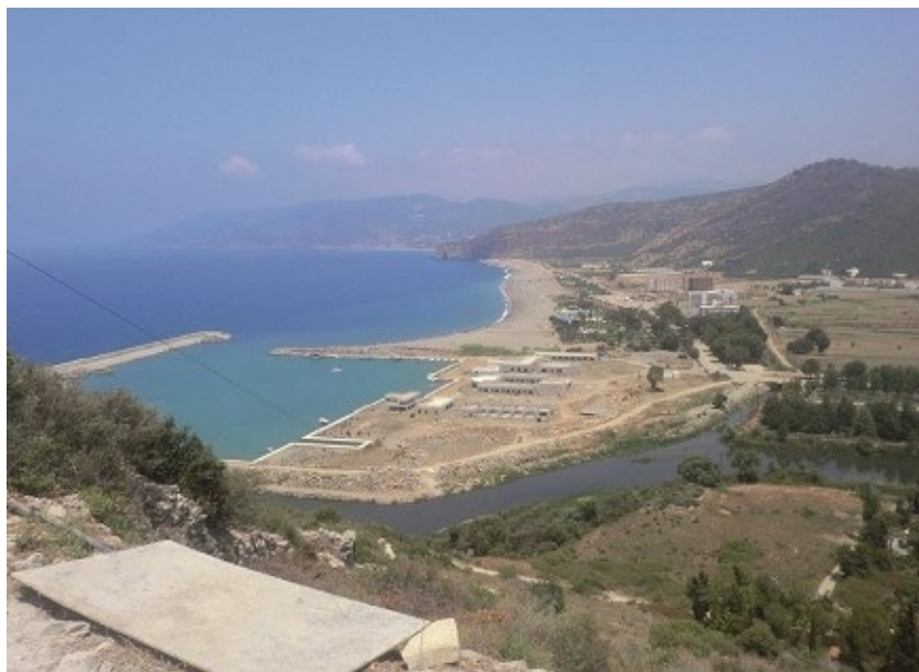
El puerto deportivo de Selinis/Gazipasa en construcción.
